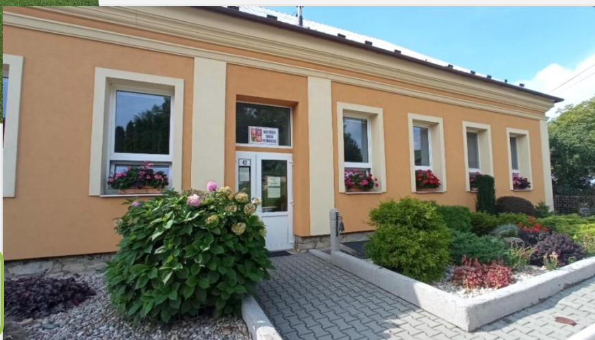
Mateřská škola v Petřkovicích.
