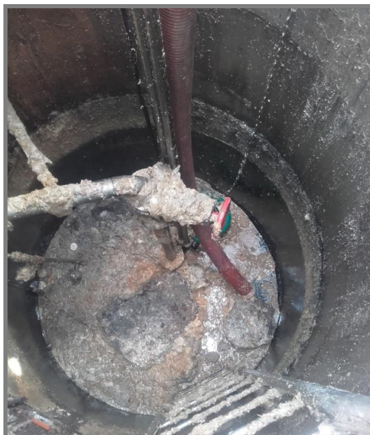
KRUSTA VLNČENÝCH UBROUSKŮ A TUKU V ČERPACÍ STANICI
